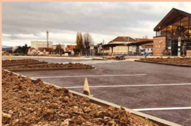
22 places "arrêt minute", dont une réservée aux personnes à mobilité réduite, ont été aménagées sur une partie du parvis. Il reste à finaliser les cheminements piétonniers et implanter les mâts d'éclairage.
