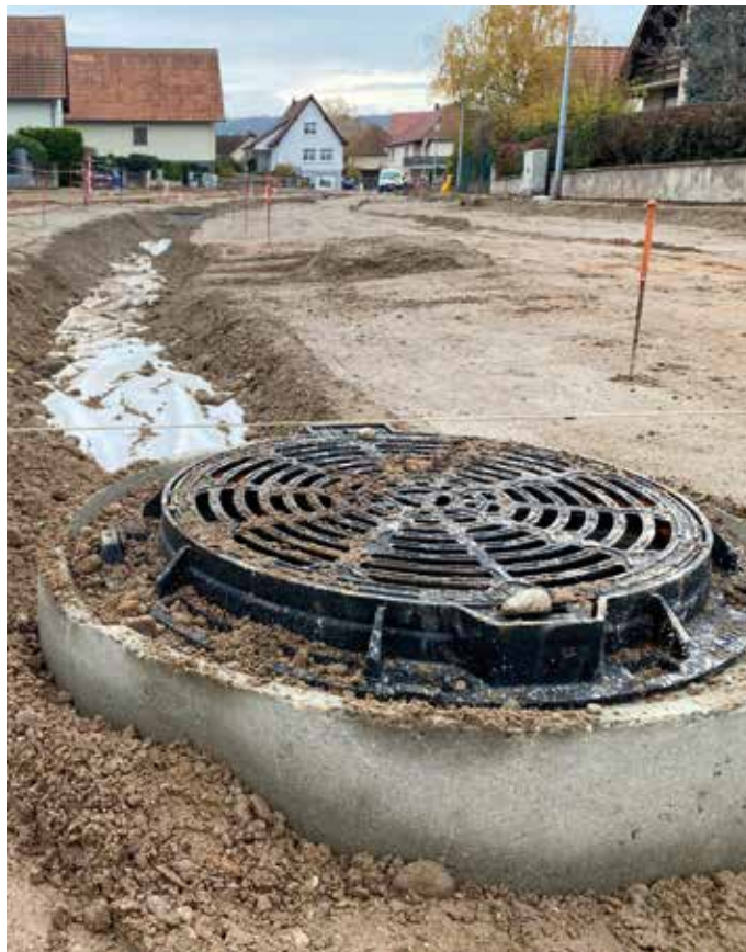
Deux noues sont implantées dans la rue de Donon. On aperçoit la membrane géotextile posée sur la couche de galets. De part et d'autre de ces dispositifs un regard permettra d'assurer l'entretien du drain. L'ensemble de ces travaux est réalisé par l'entreprise Eurovia.
