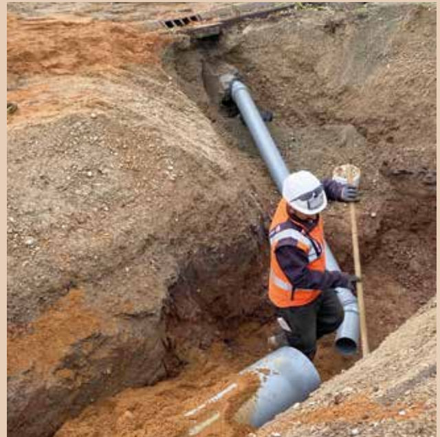
Les bouches d'égout ont toutes été déconnectées du réseau unitaire et raccordées à une nouvelle conduite qui oriente les eaux de pluie vers un exutoire.
