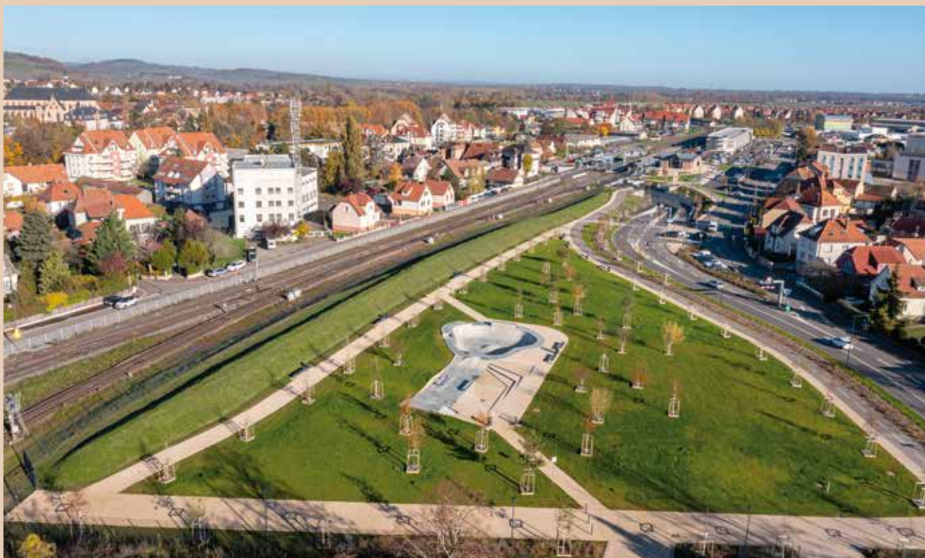
Cet automne, l'entreprise ID Verde a réensemencé l'emprise du parc de la Commanderie. Ces aménagements offrent une qualité paysagère certaine à l'entrée Sud de la Ville (Photo Drone Sessions).
