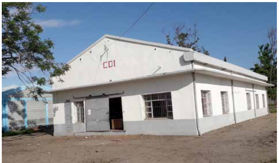
Après le passage du cyclone en février 2022, la réfection du lycée de Mananjary, a été possible grâce à l'association Fihavanana et à la Ville de Molsheim.
