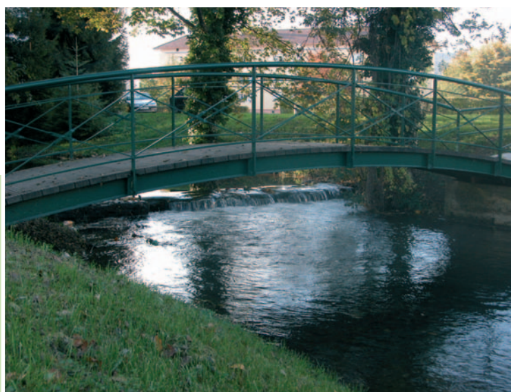
Passerelle rue Sainte Odile.
