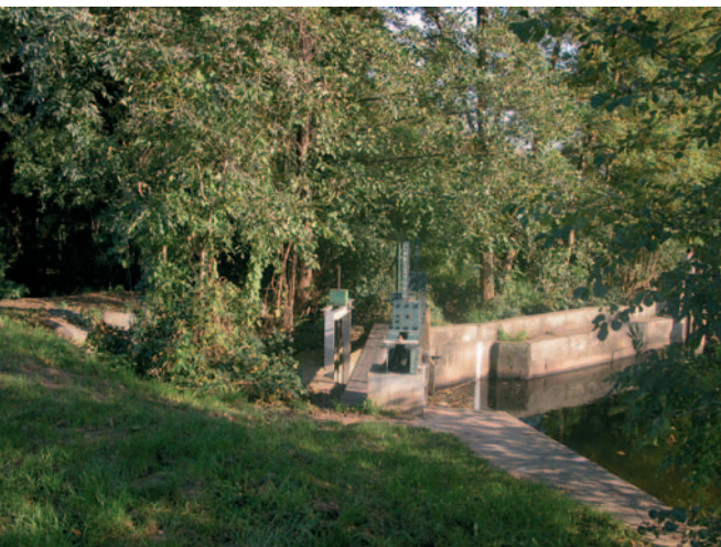
Vannes au départ du canal.
