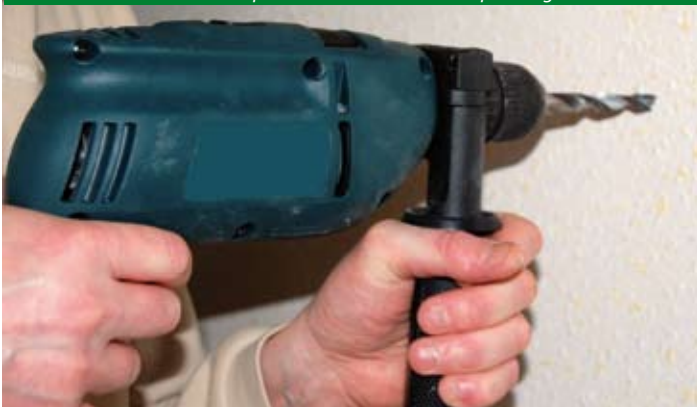
Avant d'entreprendre des travaux de rénovation ou de réparation de votre maison, informez simplement vos voisins des risques de gêne occasionnés.
