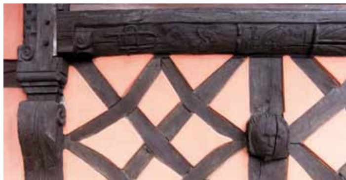
Emblème de tuilier sur un encadrement de fenêtre sculpté, montrant deux gabarits à tuiles plates croisés en sautoir, une roue solaire et le millésime 1651 (34 rue de la Boucherie).
