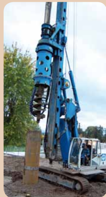
Quatre forages à 11 m de profondeur ont été réalisés de chaque côté de la Bruche avant d'injecter un coulis de béton à la base de chaque pile. ➔
