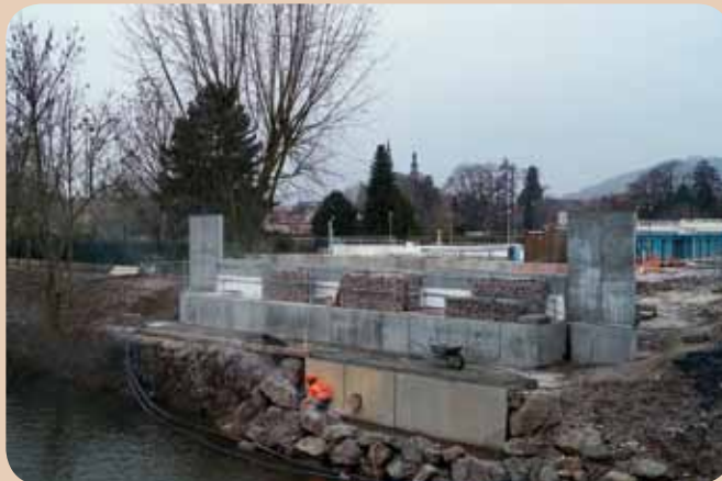
Quatre forages à 11 m de profondeur ont été réalisés de chaque côté de la Bruche avant d'injecter un coulis de béton à la base de chaque pile. ➔
