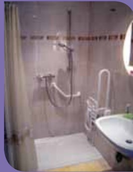
Exemple de travaux effectués dans une salle de bain. La baignoire a été arrachée et transformée en cabine de douche.
