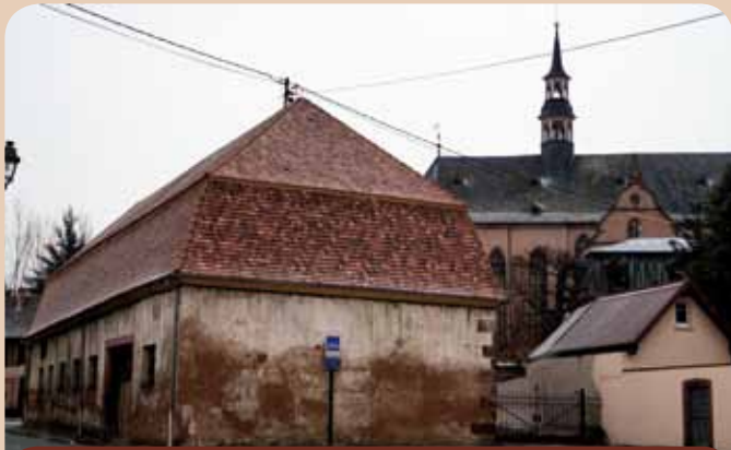
Les travaux de réfection de la toiture de l'immeuble Rohfritsch sont terminés. L'échafaudage a été enlevé fin novembre.
