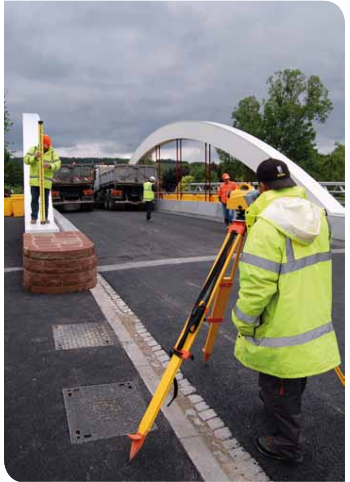
Les éventuelles déformations du pont ont été mesurées à mi-portée et aux quarts de chaque travée, ainsi que sur appuis pour les travées chargées lors de l'essai.
