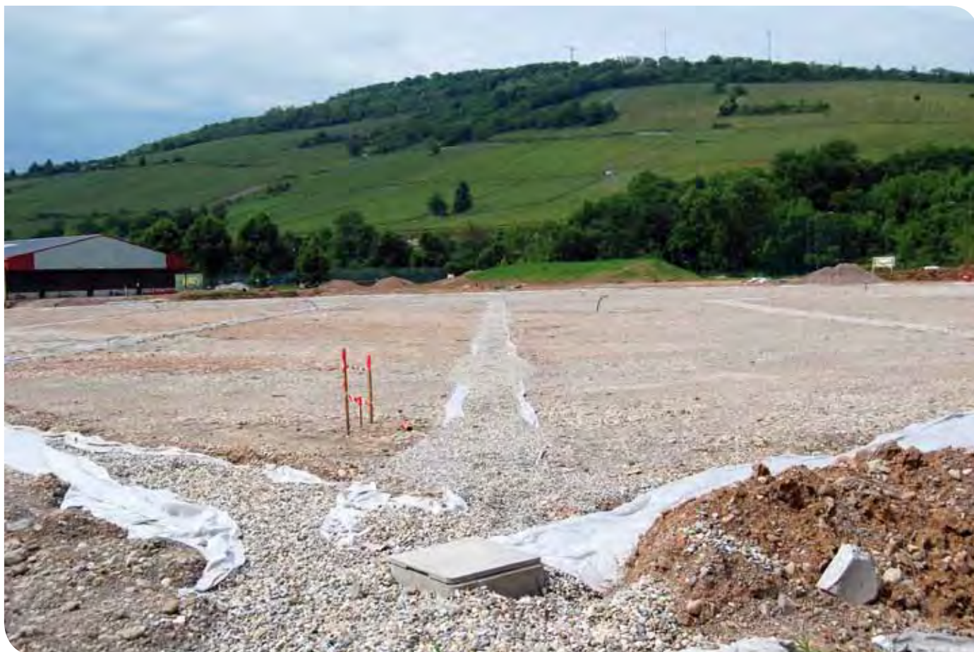
Après les opérations de terrassement et de mise en place d'un système de drainage, le terrain d'honneur attend d'être engazonné.
