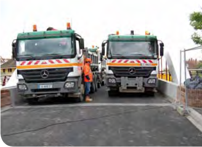
Avant l'ouverture du pont, quatre essais ont été effectués pour contrôler le comportement réel de l'ouvrage sous différentes charges.
