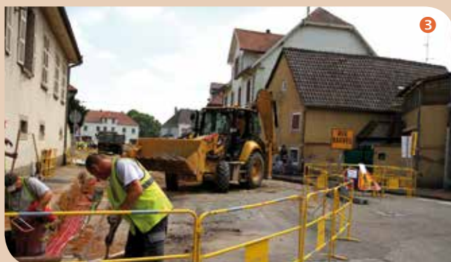
La deuxième phase a démarré le lundi 6 juin avec la dépose des pavés et la mise en œuvre de nouveaux réseaux secs en souterrain ❷ et ❸.
