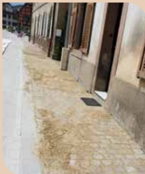
Une fois jointoyés, les pavés sont recouverts d'une couche de sciure destinée à absorber la laitance des joints.
