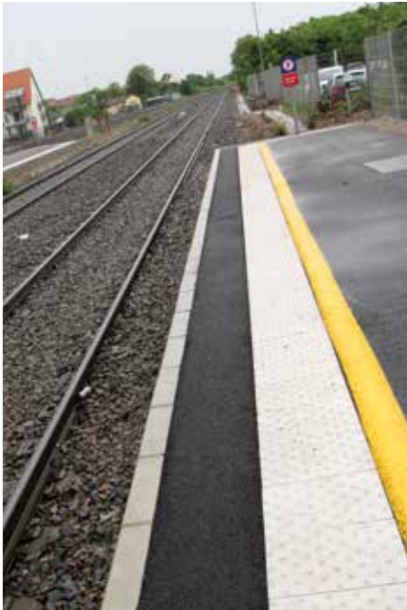
SNCF Réseau a procédé à l'allongement de la voie A pour pouvoir accueillir le nouveau matériel roulant mis en place par la Région Grand Est et a procédé à la pose de 720 m de bandes d'éveil et de vigilance.
