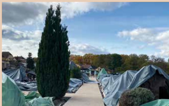
Une fois le béton coulé, il s'agit d'attendre entre 5 à 24 heures avant de retirer la couche de laitance à l'aide d'un nettoyeur à haute pression pour faire apparaître les graviers.
