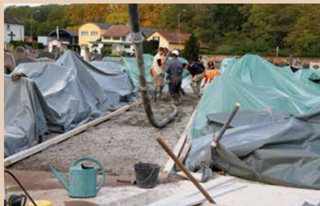
Une bonne dizaine de toupies à béton d'une capacité de 8 m 3 chacune a été nécessaire pour bétonner cette dernière tranche.
