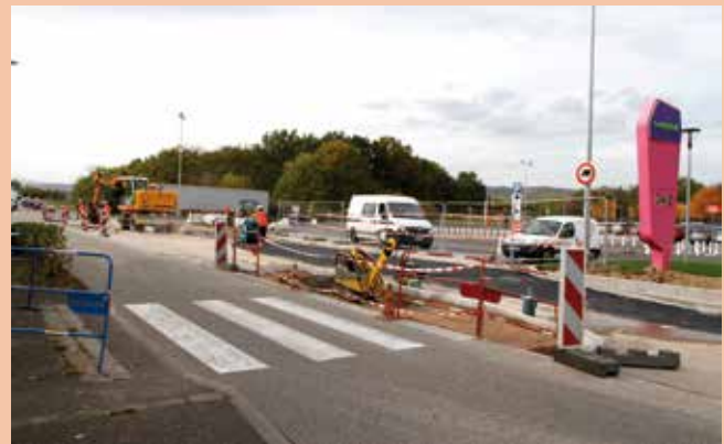
Le chantier se subdivise en quatre phases successives, deux phases côté Merck et deux phases côté piste cyclable.
