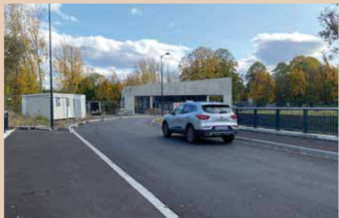
Le tronçon de voirie permettant de joindre la rue des Remparts à la rue des Sports a été ouvert mi-septembre
